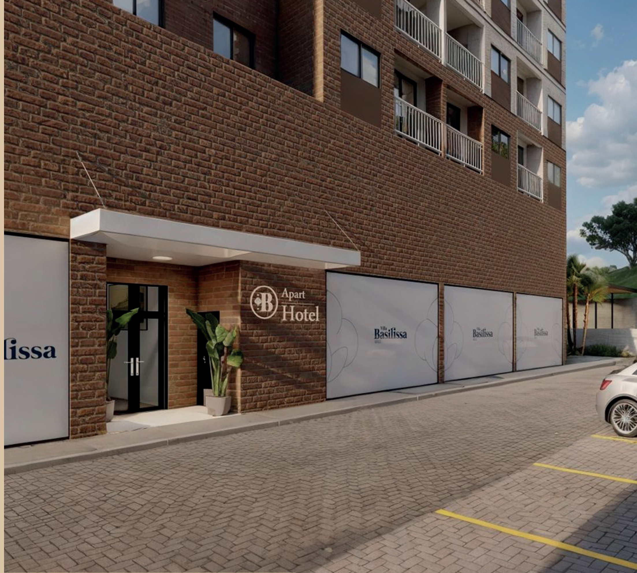
Térreo: Fachada Apart-hotel
